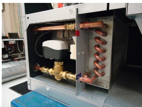
Eksempel på montering af vandvarmeplade.
