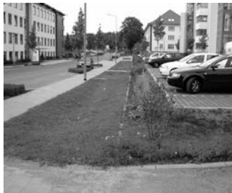
Nedsivningsgrøft af en grusrandegrøft efter færdiggørelse
