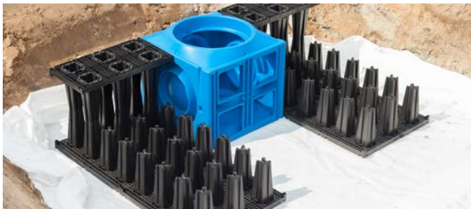
Første trin i installationen af systemet i en murstenslignende formation
