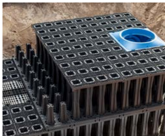
Installation af det andet lag i en murstenslignende formation
