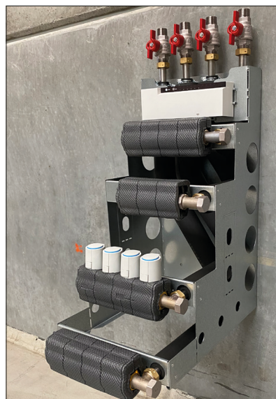
Eksempel på BUNDMODUL med ekstra tilbehør; ventiler, gulvvarmestyring og telestater.
